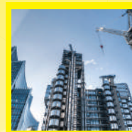
Công Trường Xây Dựng
